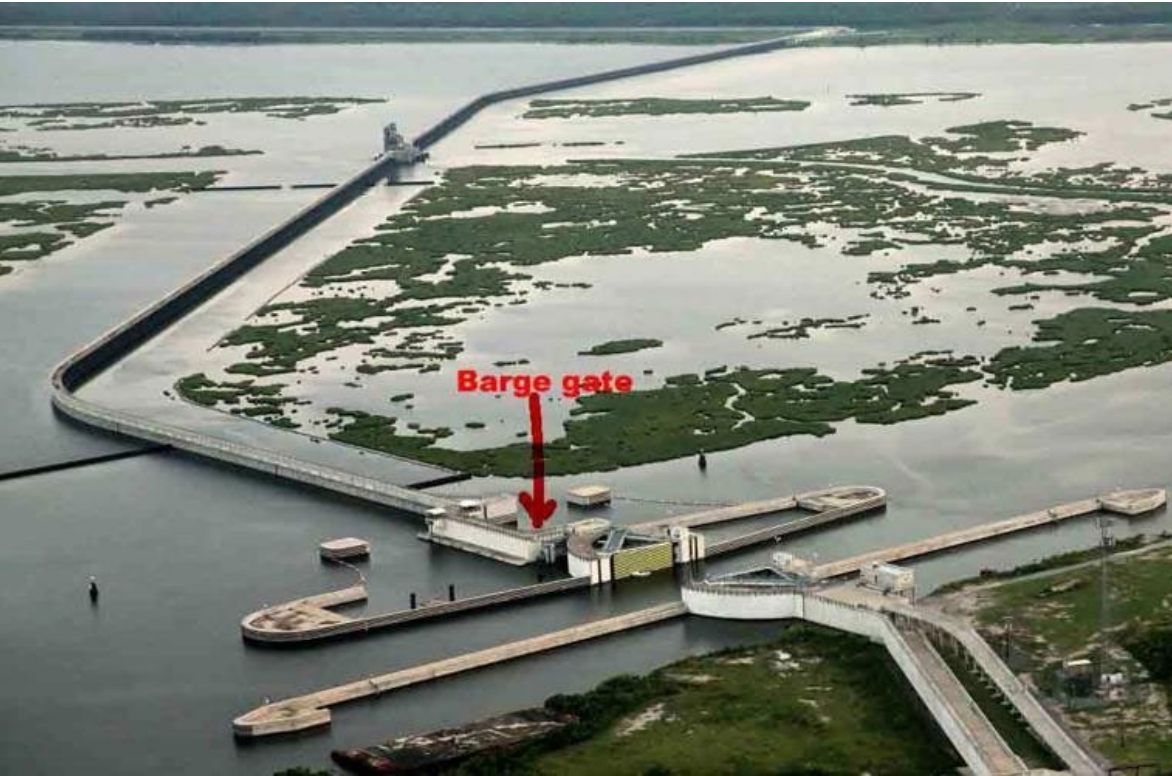
Figure: IHNC Barge gate (USACE NOLA)
